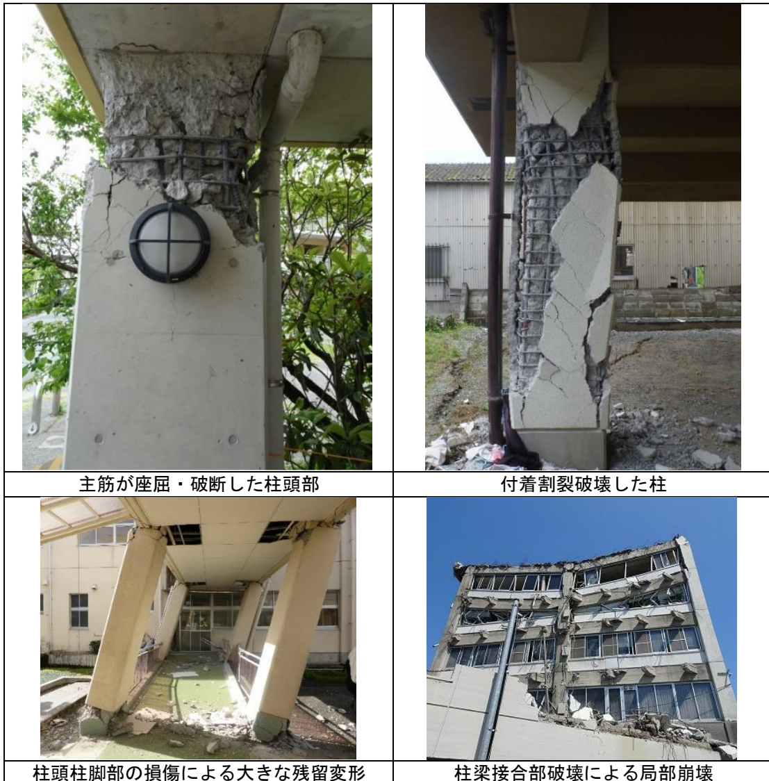
写真：熊本地震における建築物被害の原因分析を行う委員会報告書
