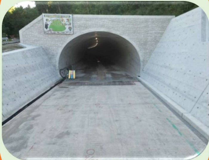
覆工コンクリート完成
