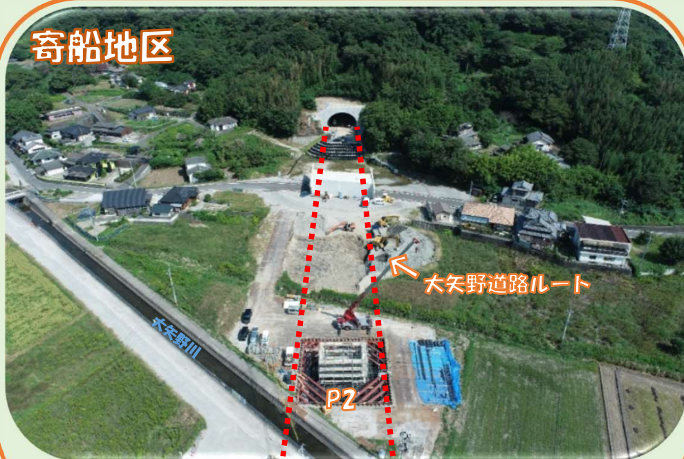
大矢野川を跨ぐ(仮称)上1号橋の下部工(P2橋脚)工事の状況
