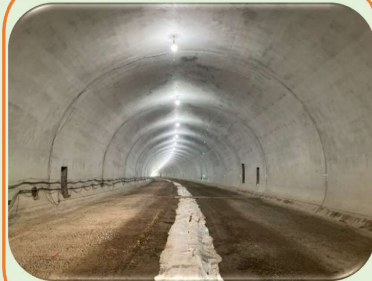
現在のトンネル内部
