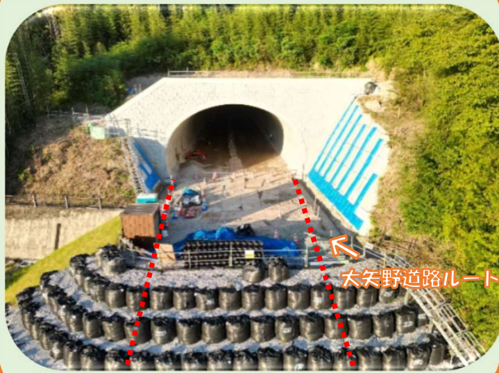
覆工コンクリート完成
