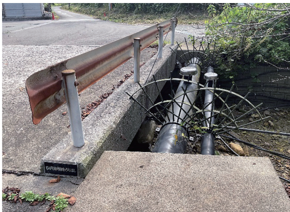
▲補修工事を行う東成川内橋（姫戸町姫浦）
