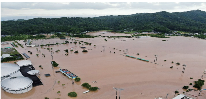
▲冠水した松島総合運動公園周辺一帯
